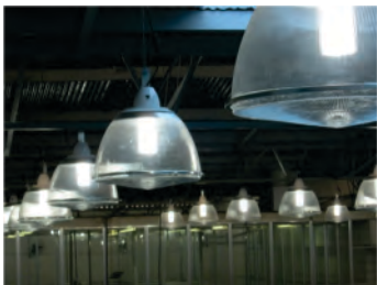
MELHORIAS: troca de luminárias
