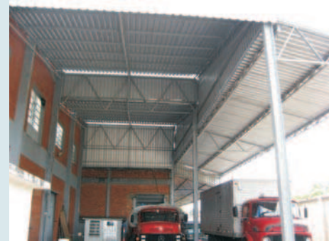
PAVILHÃO: cobertura para Carga Direta
